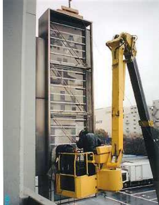
外壁・屋上看板 (平和島・東京流通センター) 延 600 本設置 昼光色 (平成 9 年 2 月より)
